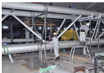
組み付け作業
