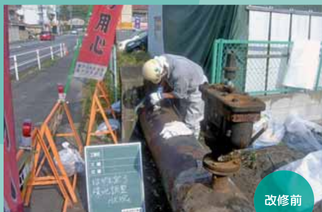
パイプビーム形式水管橋補修工事
