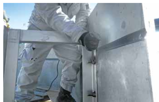
支持金具設置工
