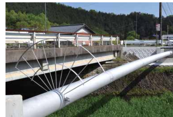
岐阜県内 SUS304 150A/SUS304 250A 支間長 16.1m
