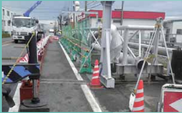
静岡県内 トラス補剛形式水管橋 製作架設工事
