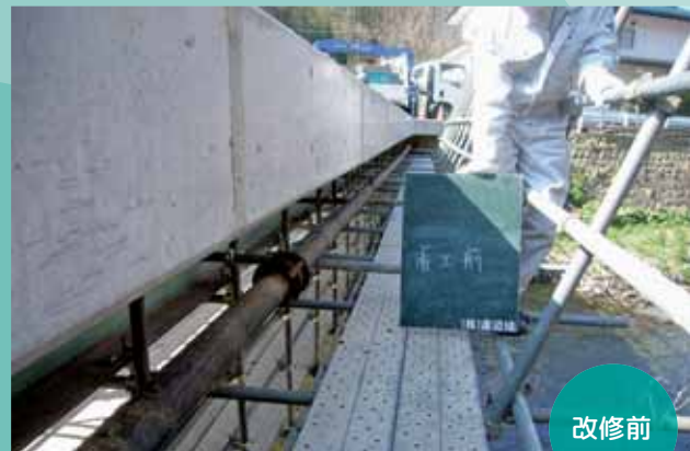
本管外面塗り替え及び FRP 保温取り替え工事
