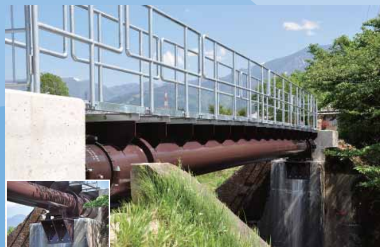
岐阜県内 塗覆装鋼管 STPY400 500A 支間長 11.3m
