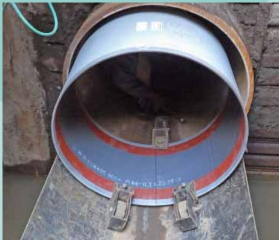
名古屋市上下水道局 パイプインパイプ工事
