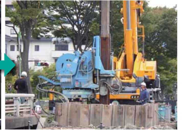
鋼矢板圧入工事
