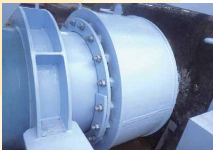
リペアジョイント取付後
