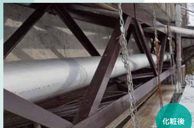
塗覆装鋼管 300A 撤去 SUS304 250A 取替
