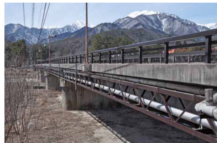
長野県内補修工事 SUS304 250A 支間長 150.0m
