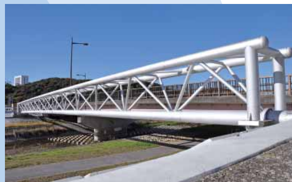
愛知県内 上弦材 SUS304 350A 支間長 59.0m 下弦材(通水管) SUS304 500A 斜材 SUS304 125A
