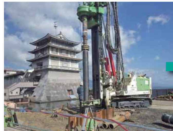
杭回転圧入工事
