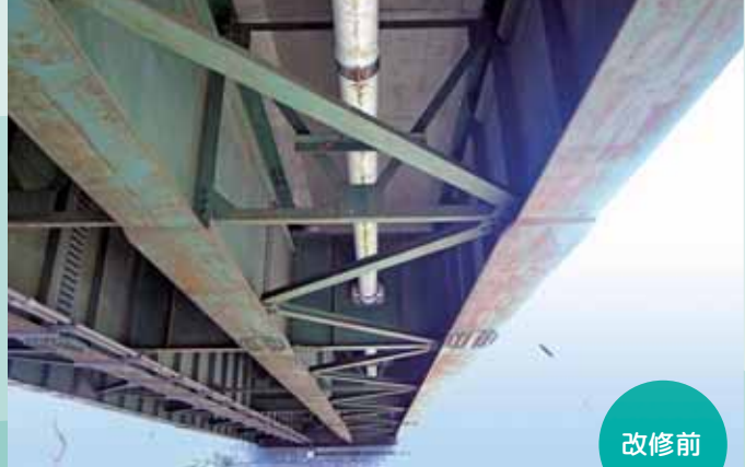
橋梁及び添架水管橋 改修工事
