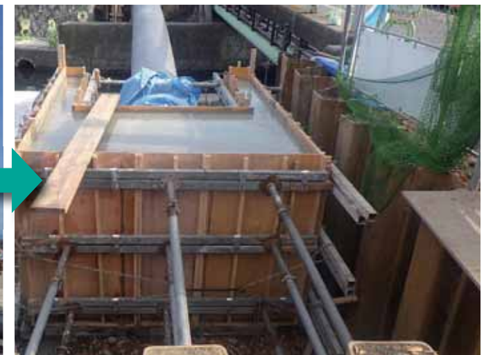
コンクリート打設工事
