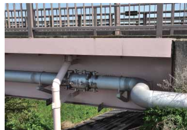
茨城県内 伸縮管補強工事
