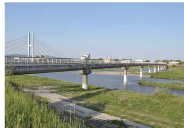
兵庫県内 落橋防止・耐震補強工事
