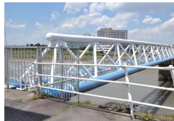
愛知県内 落橋防止・耐震補強工事
