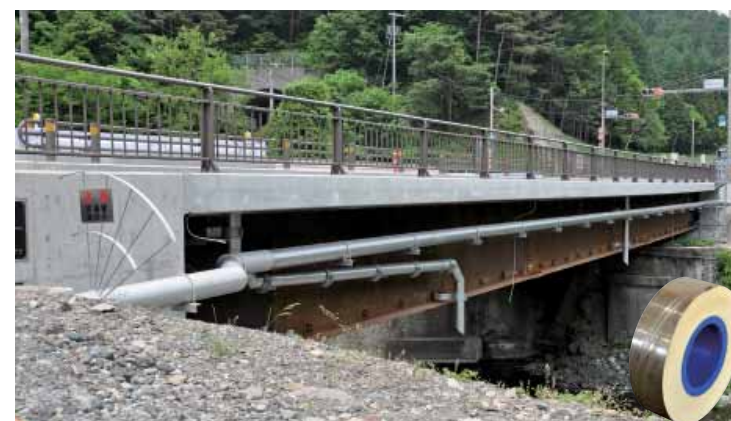
長野県内 上水道 橋梁添架管形式水管橋 配水用ポリエチレンパイプ 150A / SUS304 スパイラル管 0.8mm φ 250 支間長 115.0m
