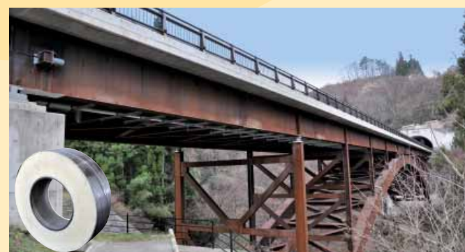
長野県内 上水道 橋梁添架管形式水管橋 SUS304TP 100A / SUS304 スパイラル管φ200 0.8mm 支間長 140.0m
