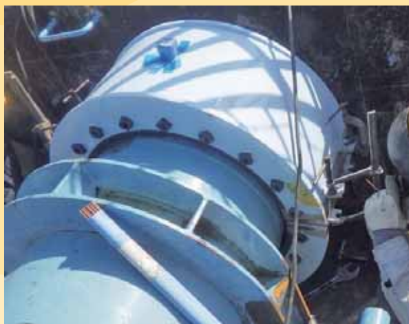
愛知県内 リペアジョイント取付工事
