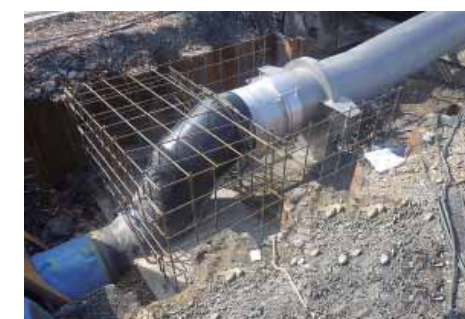
橋台内配管布設工
