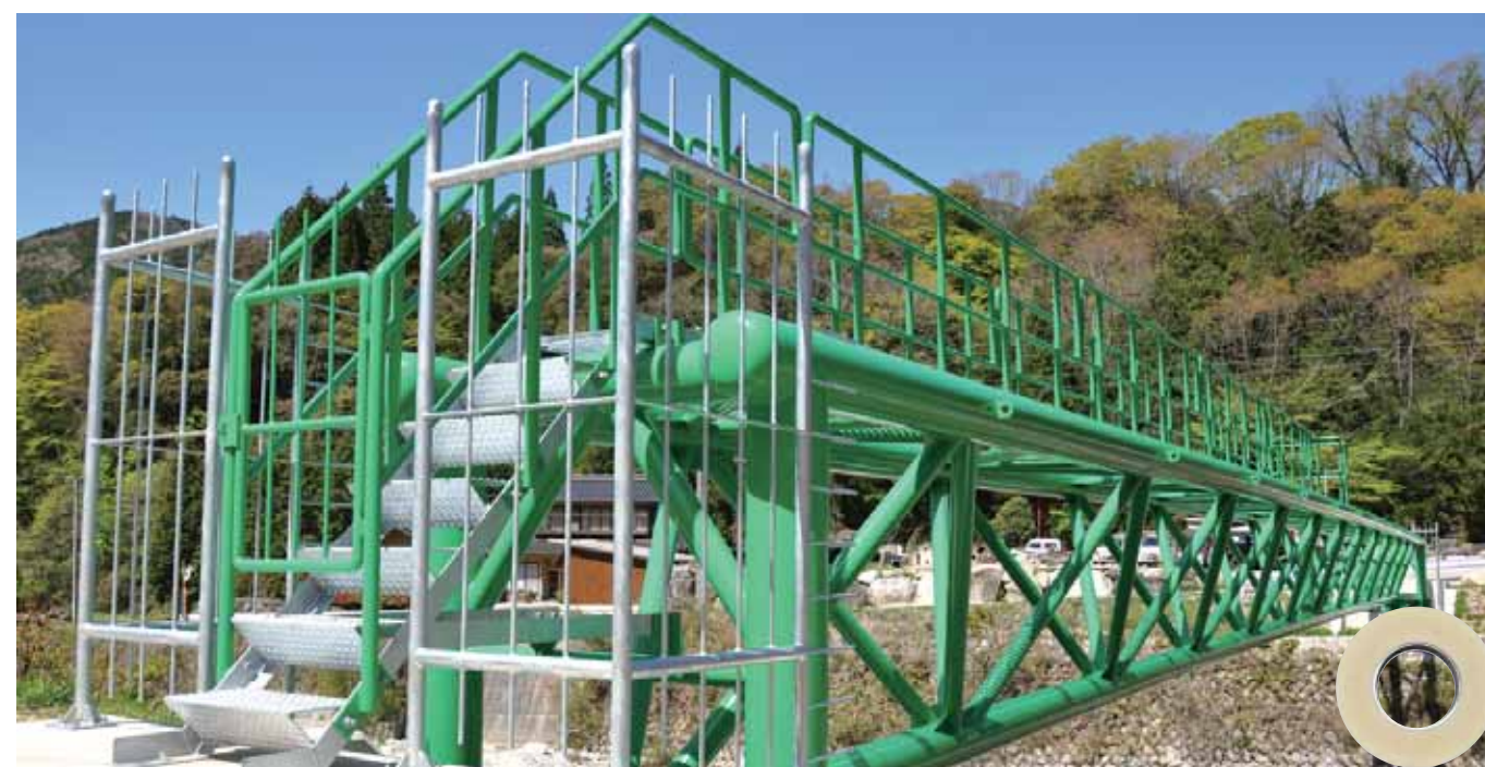
岐阜県内 上水道 逆三角形トラス補剛型式水管橋 SUS304 100A / STK400 200A 支間長 38.0m
