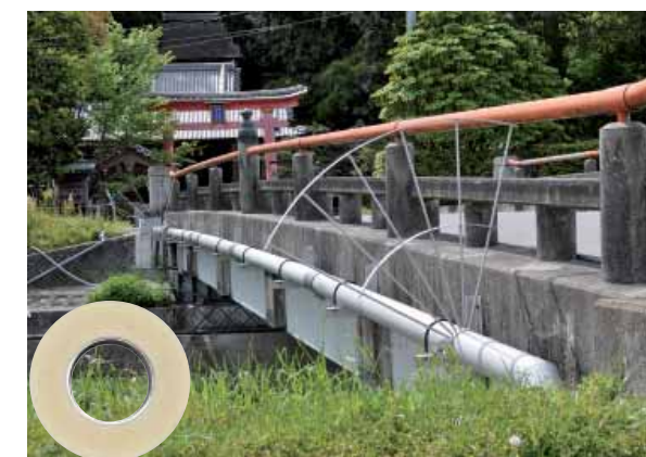
三重県内 上水道 橋梁添架管形式水管橋 SUS304TP 75A / SUS304 スパイラル管 0.8mm φ 150
