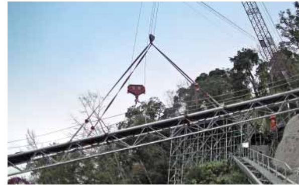
静岡県内 トラス補剛形式水管橋 製作架設工事
