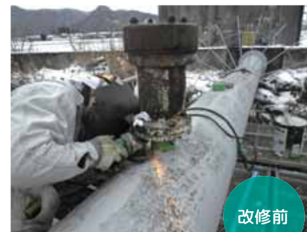
漏水補修工事
