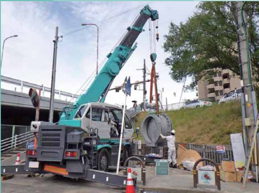
兵庫県 バタフライバルブ設置工事
