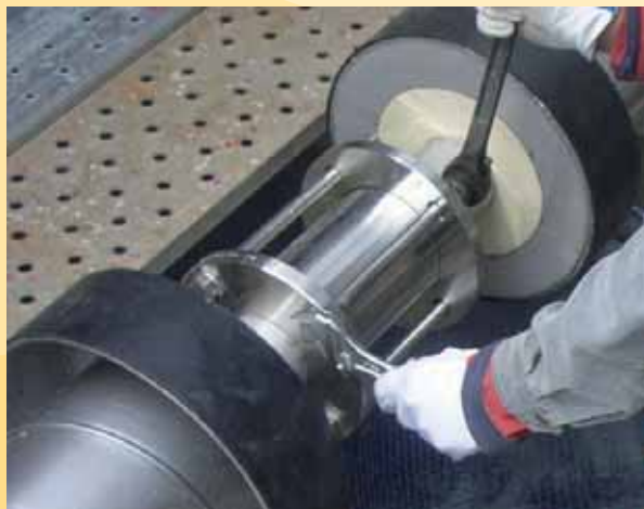
長野県内 SNK 伸縮管取付工事
