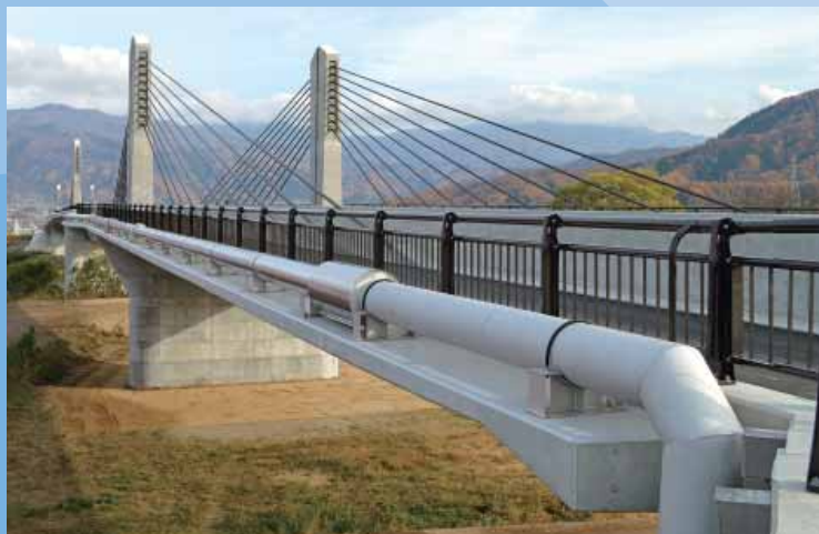
長野県内 SUS304TP 300A/SUS304 内ハゼスパイラル管 400A 支間長 380.0m
