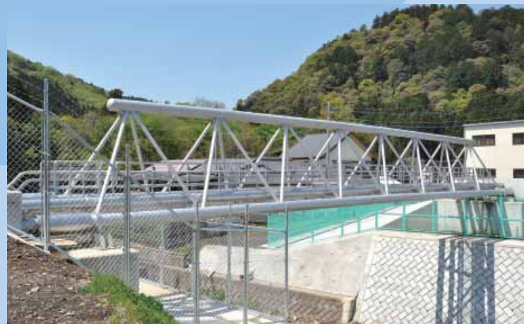
茨城県内 上弦材 SUS304 250A 支間長 20.7 m 下弦(通水管) SUS304 100A/200A 添架管(通水管) SUS304 80A/200A
