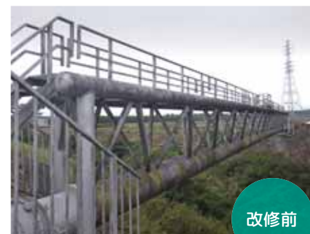
水管橋塗装工事
